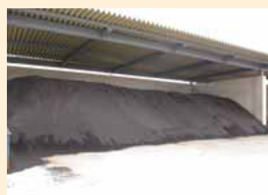
▲敷地内に集められた溶融スラグ
