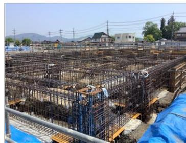
4月は、基礎の鉄筋工事を行いました。ベース→柱→梁の順番で建物の骨組みとなる基礎を施工しました。
