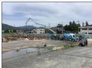
5月は、主に基礎型枠工事をしました。6月も引き続き型枠の建込を行い、順次基礎コンクリートを打設していきます。
