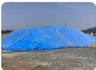
根伐り工事の掘削で発生した土は、後の埋戻しで使用する為、場内に仮置きしています。雨による土砂崩れや強風による風散がないように、ブルーシートとネットで養生しております。
