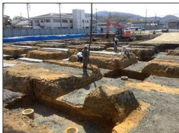
3月は、根切り工事をしました。バックホーを使用し、土を掘削し、碎石を敷き均して、捨てコンクリートを打設しました。
