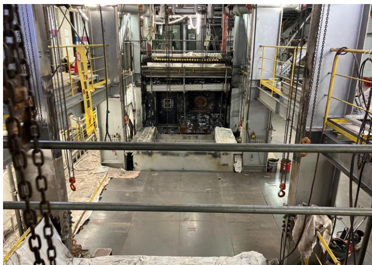
燃焼設備解体後
