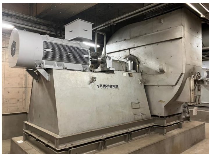
誘引通風機電動機据付完了
